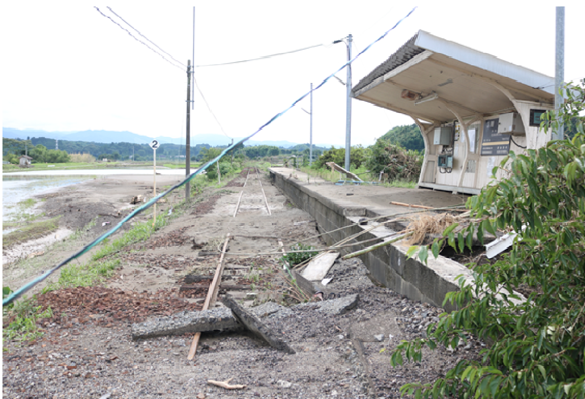
相良村川村駅 (被災状況)
