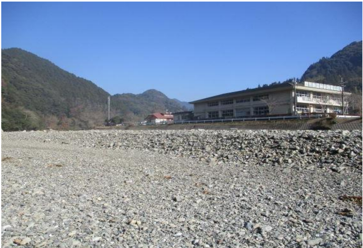
山江村 まえば 万江川堆積土砂（万江小学校付近）
