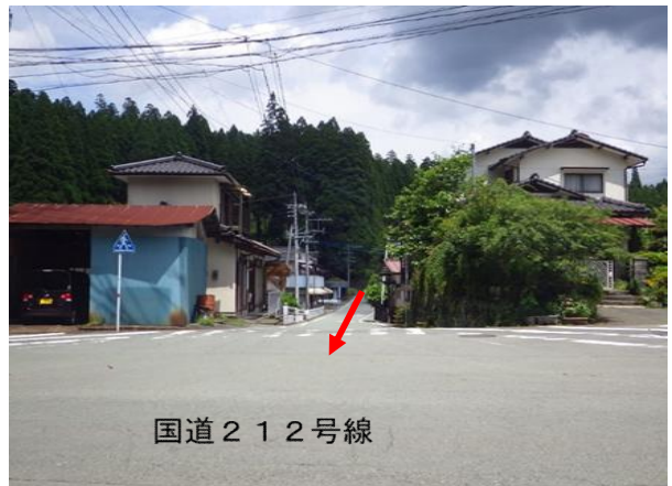
⑯(終点部分)未改良区間
