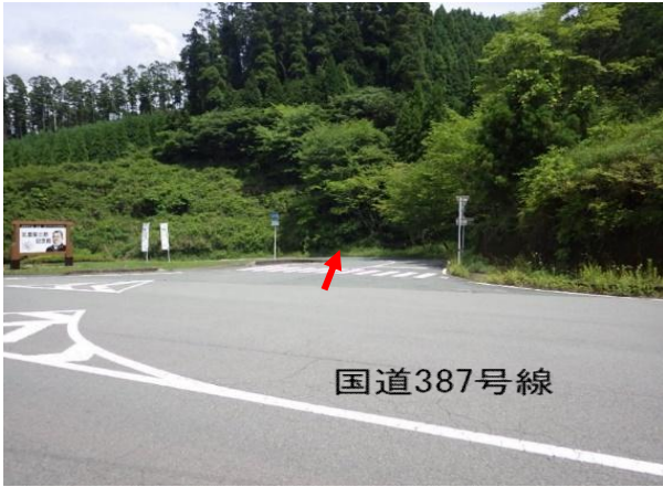
① (起点) 改良済区間
