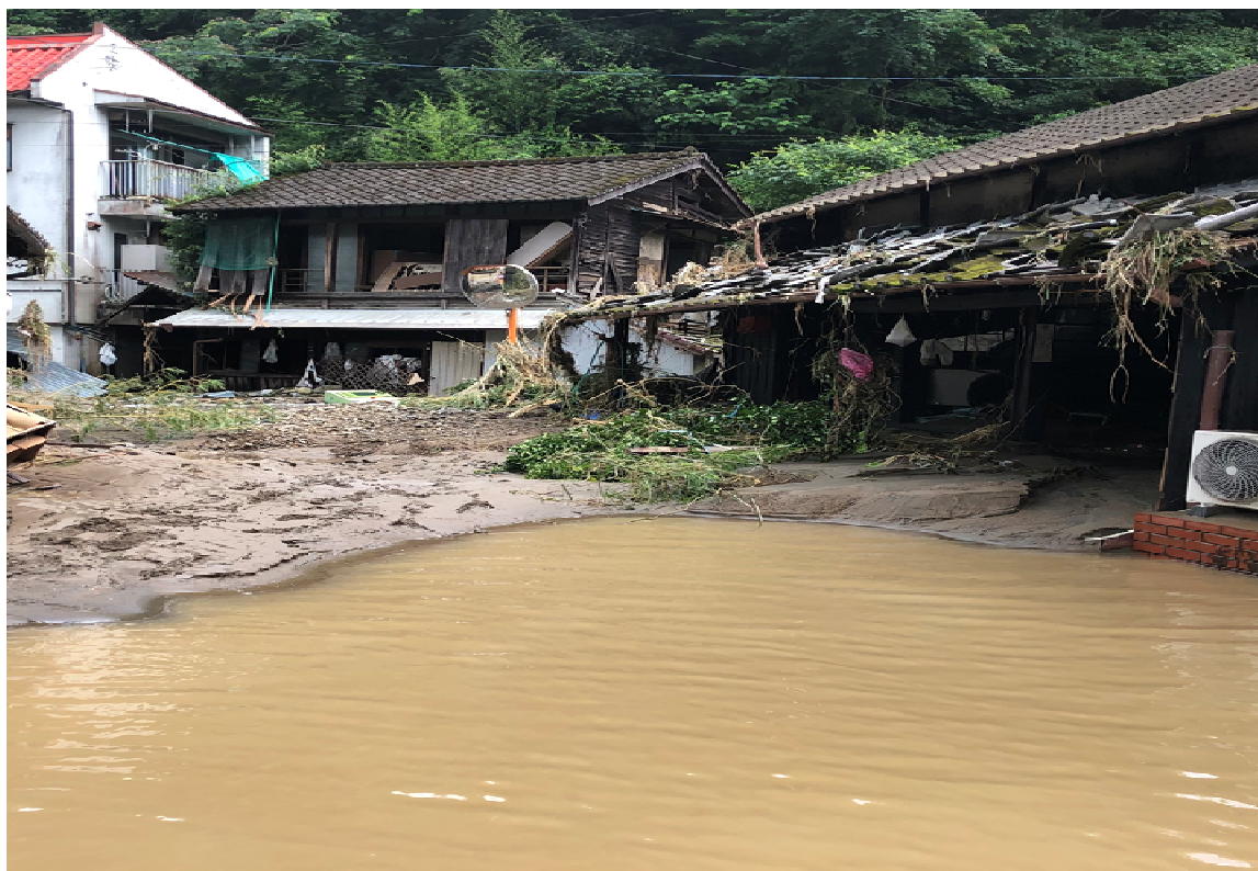
球磨村一勝地（被災状況）
