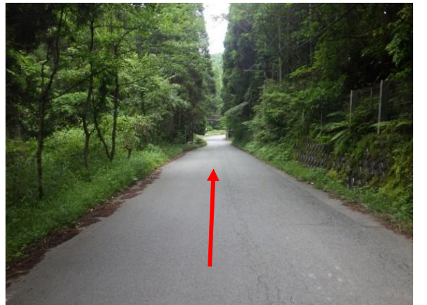
⑦未改良区間
