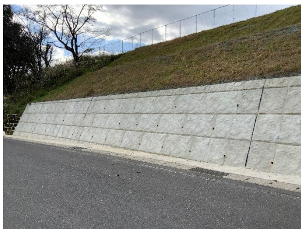
[修復が完了した法面]
