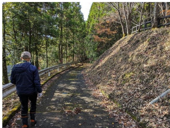
[整備された鶉の子滝周辺の遊歩道]
