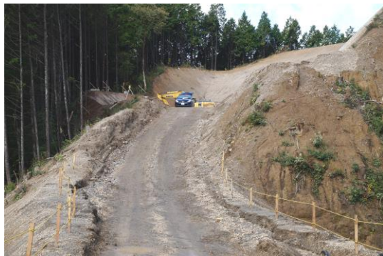
大川大矢線 本線改良工事
