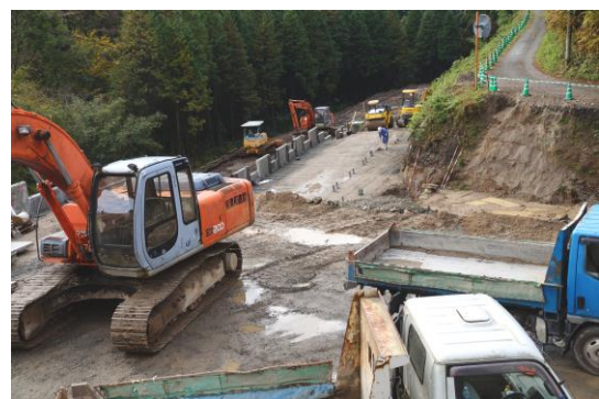
取付道路工事
