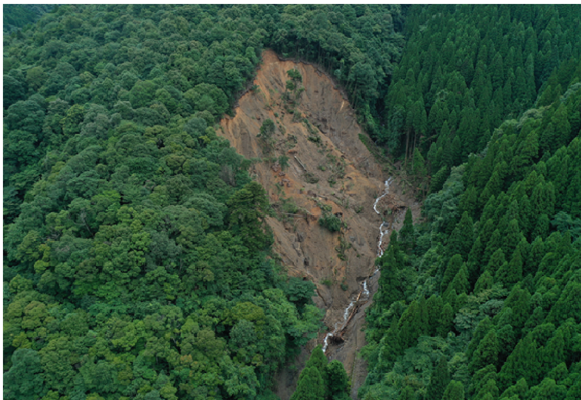
湯前町 まきらがわ 牧良川周辺（被災状況）
