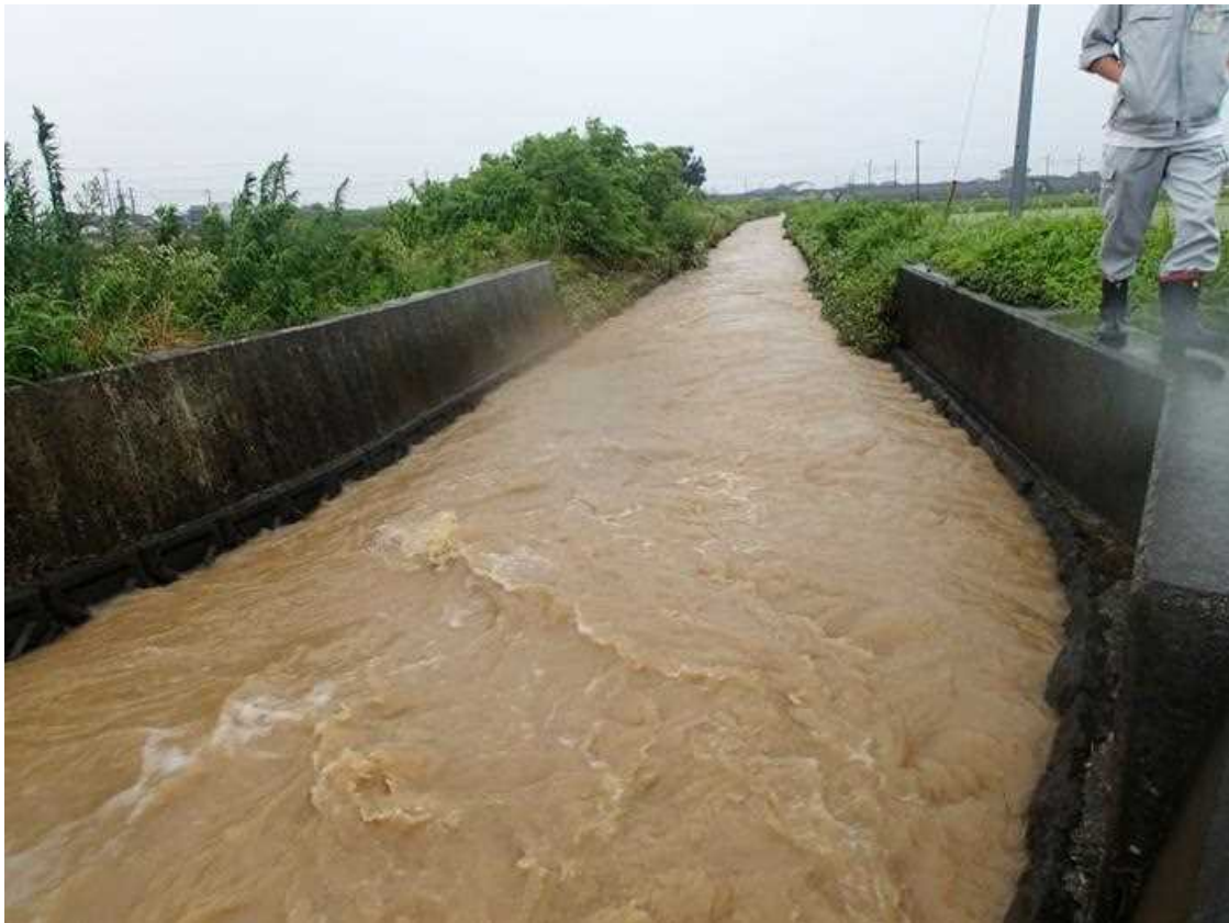
八間川増水状況
