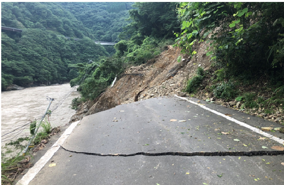
五木村村道川辺川線（被災状況）
