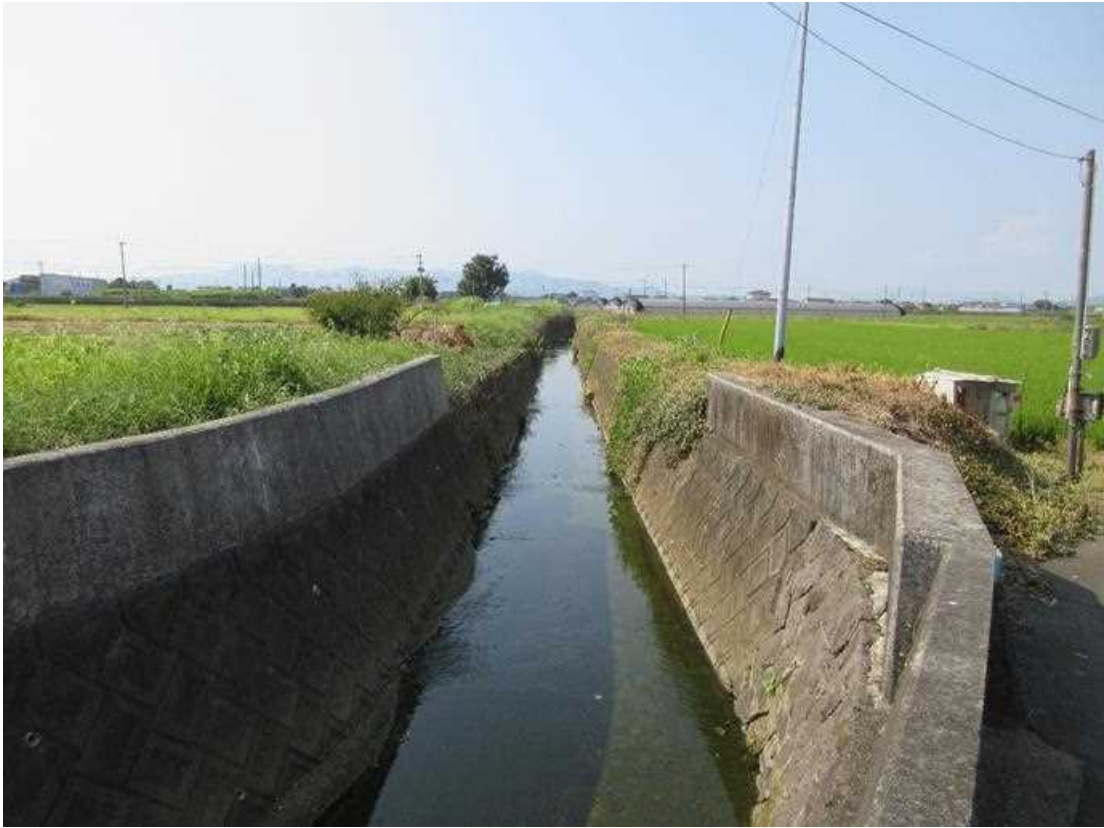
八間川護岸現況
