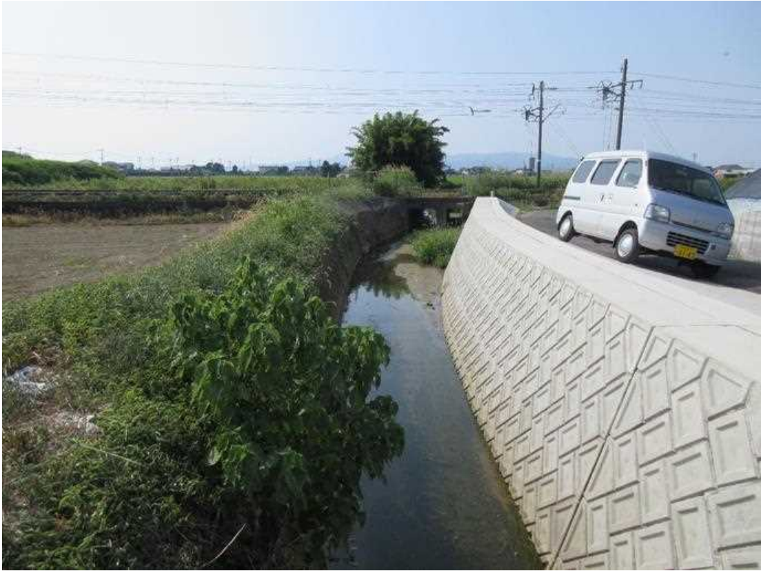
八間川護岸現況
