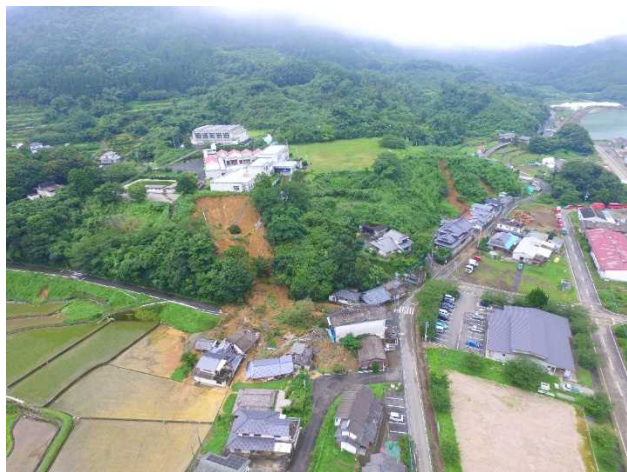
法面崩壊 (津奈木町・旧平国 ひらくに 小学校)
