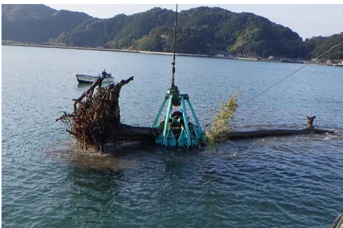
流木の撤去状況 (芦北町・女島 めしま 沖)
