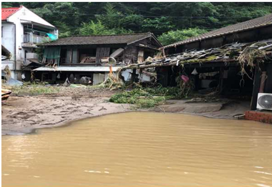
球磨村一勝地（被災状況）
