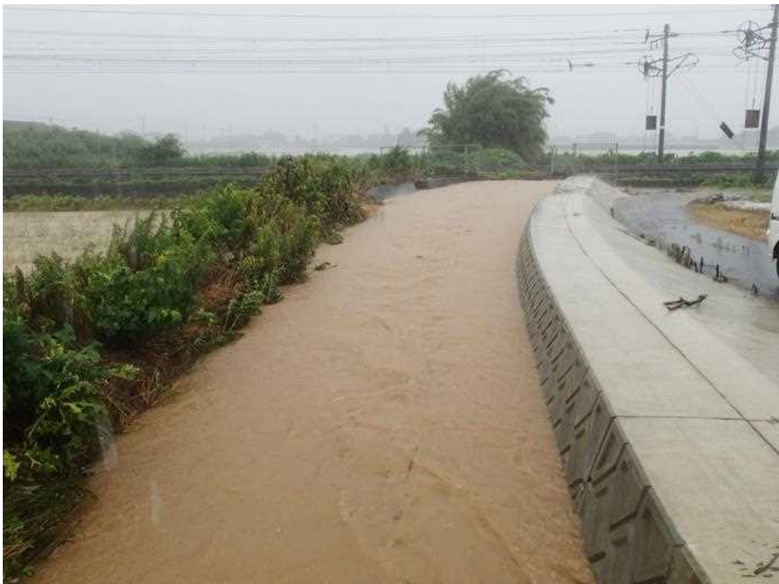
八間川増水状況
