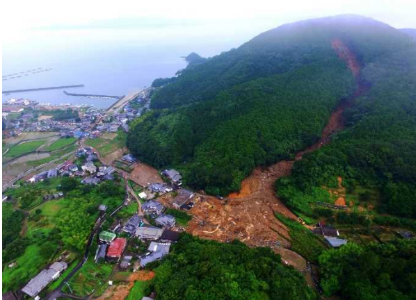
山腹崩壊 (津奈木町・平国 ひらくにしも 下地区)
