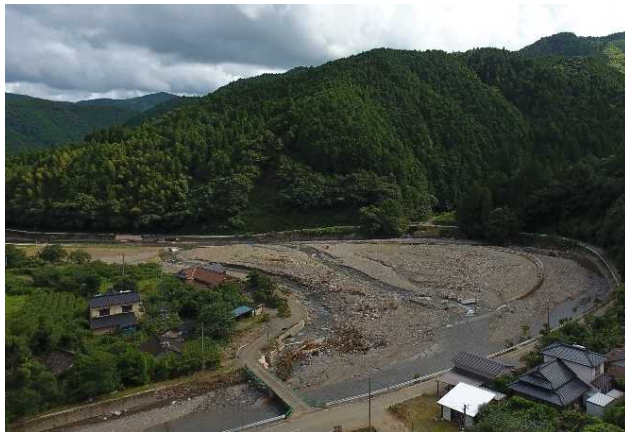
大量の土砂が流入し埋め尽くされた農地 (芦北町・大岩地区)
