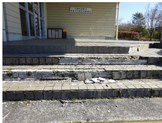
[林業者体育館 昇降口階段]
