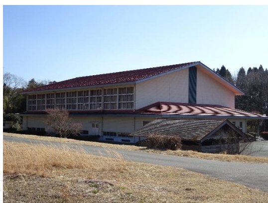
[屋根の防水工事が行われた]
