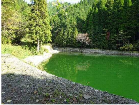
竣工後の石堂のため池
