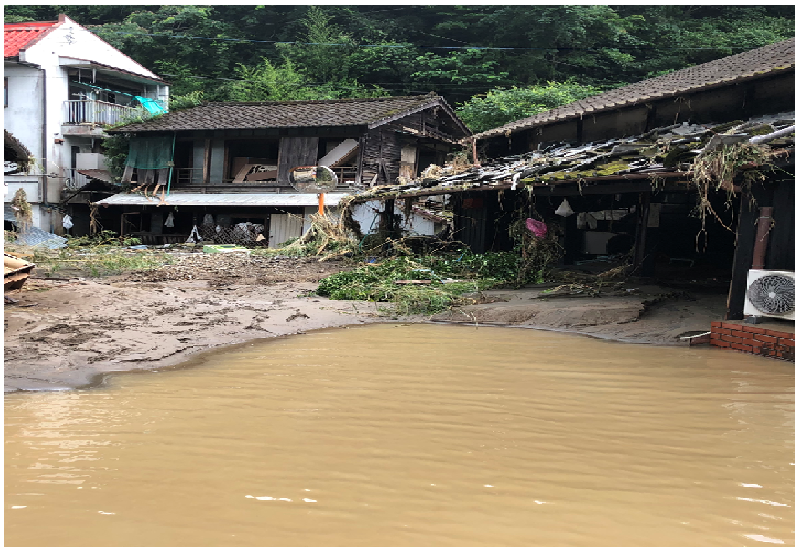
球磨村一勝地（被災状況）
