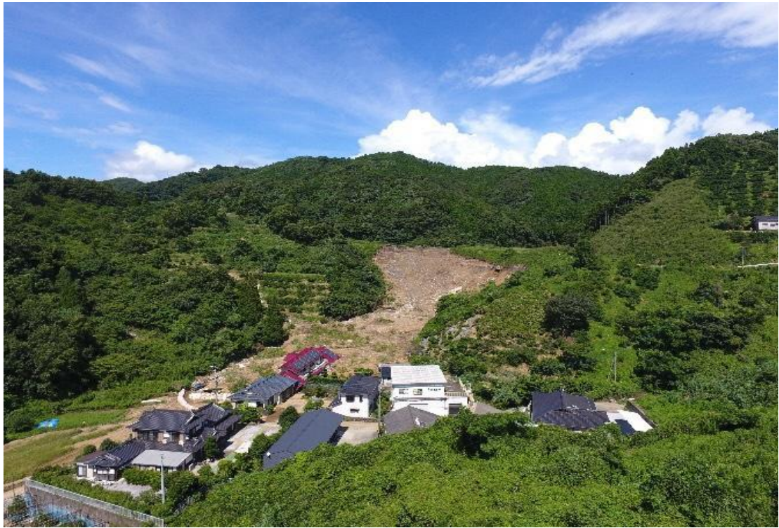
山腹崩壊 (芦北町・ つるぎやま 鶴木山地区)
