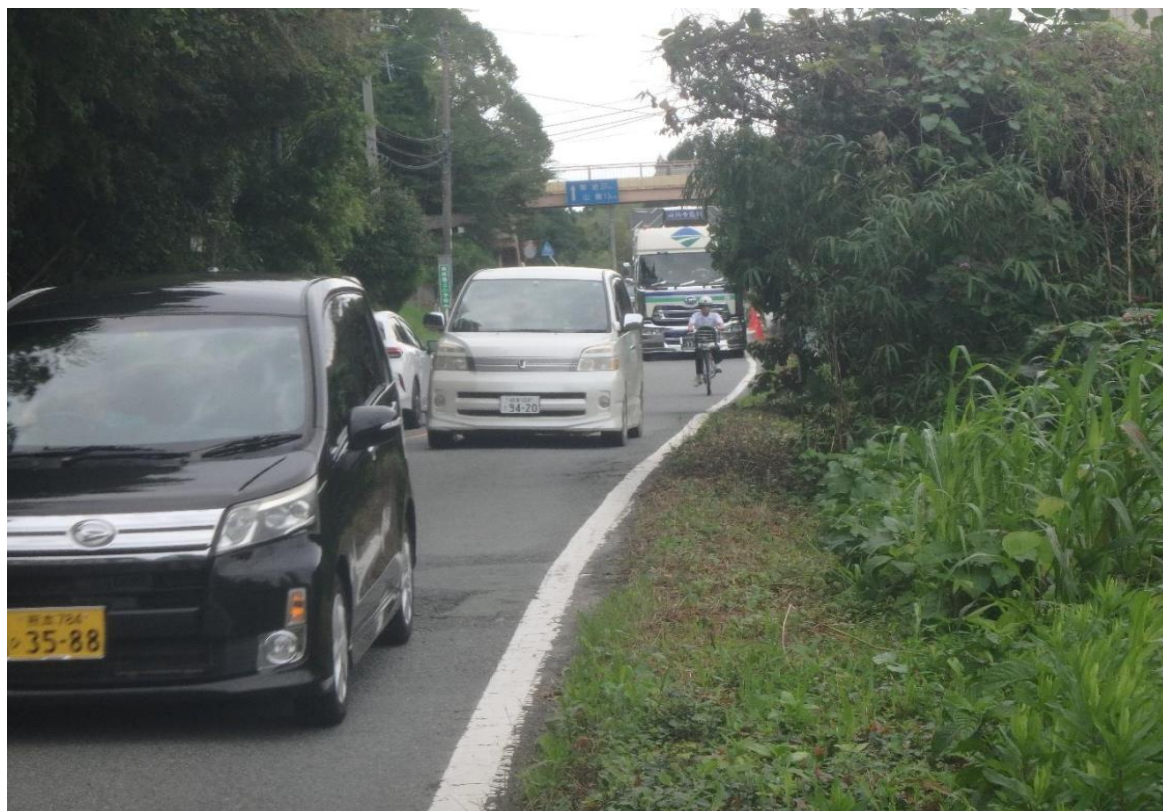
南関町相谷地内: 南関町立第3小学校付近(拡幅改良・歩道整備)
