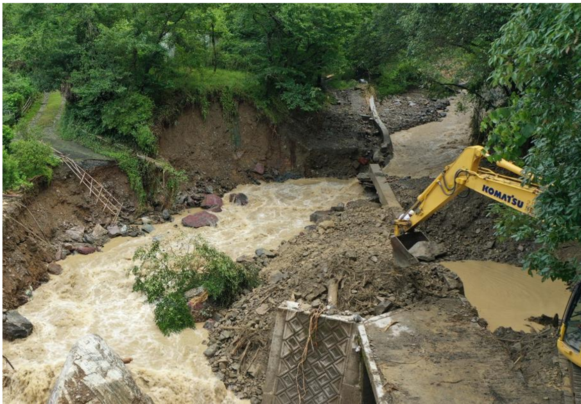
湯前町牧良線（被災状況）
