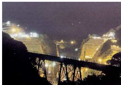
夜間工事中の立野ダム
