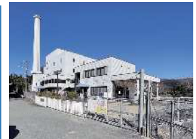
解体予定の東部清掃工場
