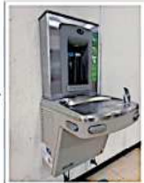
非接触式で感染症予防対応 ※触らずにマイボトルに汲めます！
