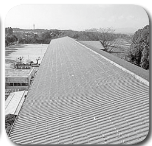
雨漏りによる 上小学校屋根改修
