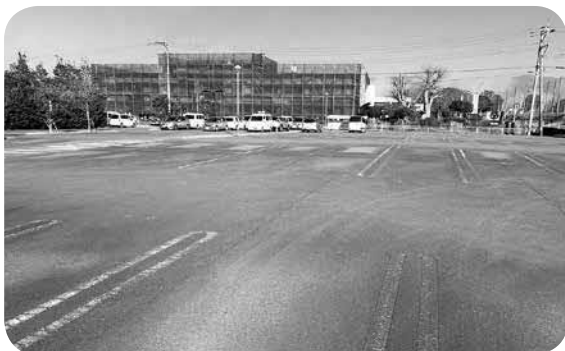
第2庁舎建設予定地の駐車場
